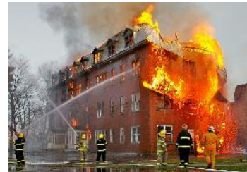
Abb. 1: Löscharbeiten der Feuerwehr [1]
